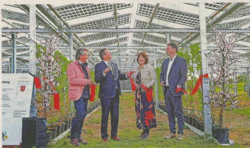
Agri-PV-Anlage eröffnet: LVWO-Chef Dieter Blankenhorn, Minister Peter Hauk, Staatssekretärin Gisela Splett, Bürgermeister Timo Frey (von links). Foto: Ralf Seidel
